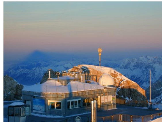
Abb.1: Gipfelobservatorium des KIT auf der Zugspitze mit Kuppel für die Langzeit-Infrarot-Vertikalsondierung des atmosphärischen Gesamtgehalts an Kohlendioxid (Foto: KIT).
