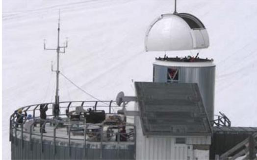
**Abb.4:** Zusammenbau des Empfängerkabinetts auf der Dachterrasse der UFS. Hier wird gerade die Kuppel mit einem großen Hubschrauber mit Doppelrotor angeliefert.
