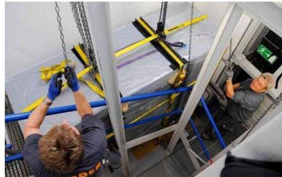
**Abb.3:** Der XeCl-Laser (Coherent, Lambda SX) beim Hochziehen im Treppenhaus zum Lidar-Labor
