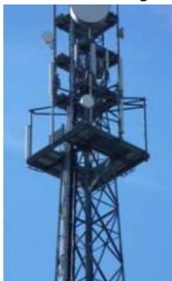
Abb.1: Ein Turm mit Richtfunkantennen
