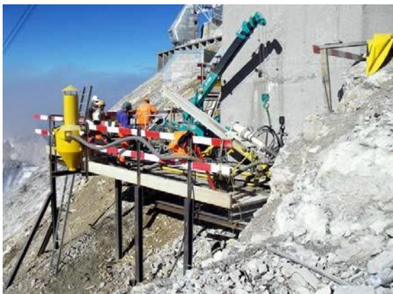
**Abb.1:** August 2007, die Bohrlafette ist aufgebaut. Nach drei Tagen war der Grat durchbohrt.
