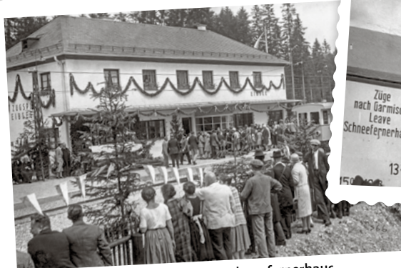
1930 Eröffnung Strecke Eibsee bis Schneefernerhaus
